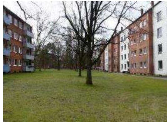
Großbaum zwischen Gebäudezeilen
