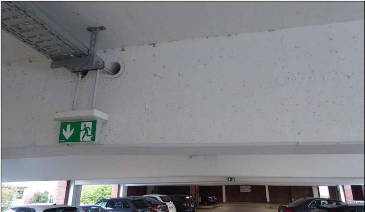
**Abbildung 3: Einschichtige Wände und Decken des Parkhauses ohne Verkleidungen**
