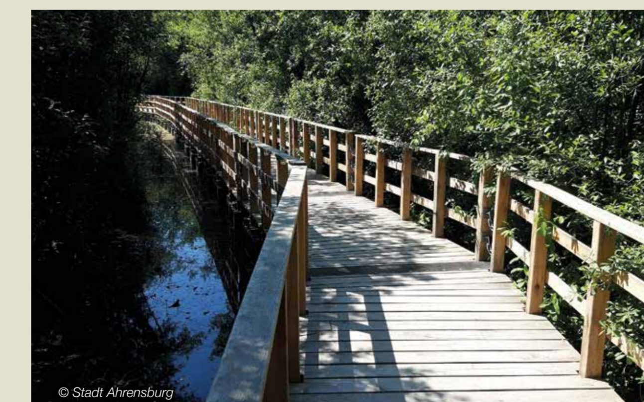
Der Wanderweg über die Moorbrücke (320 m) ist Teil eines umfangreichen Wegenetzes.
